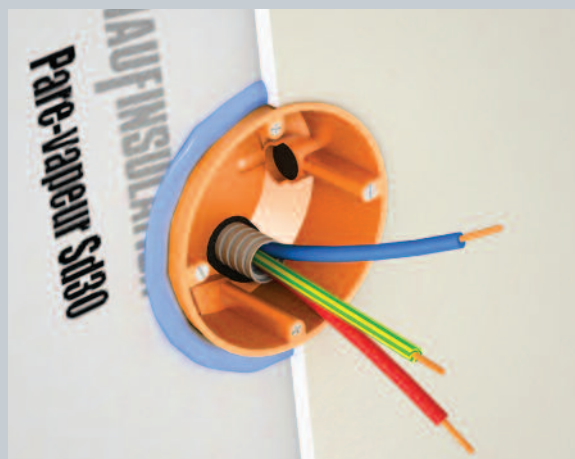
8 Raccordement sur pot électrique étanche à l'aide de la colle Solimur
