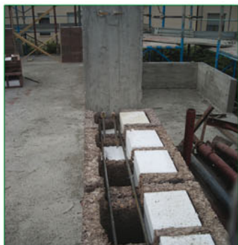
Mur relié par ferrailage à la structure
