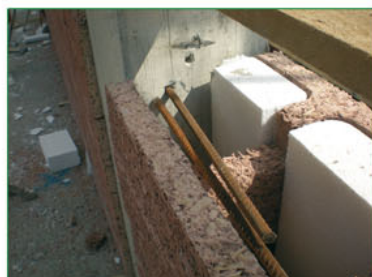
Mur relié par ferrailage à la structure
