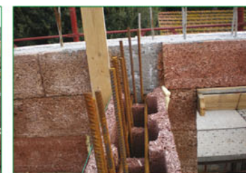
Connexion entre un mur extérieur et un refend acoustique
