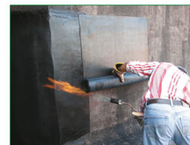
Etanchéité posée au chalumeau
