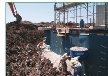
Etanchéité posée au chalumeau
