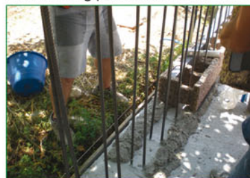
Premier rang posé sur un lit de mortier
