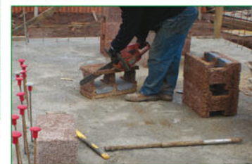
Connexion entre un mur extérieur et un refend acoustique
