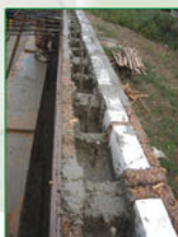
Les murs sont coulés
