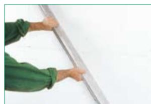
Contrôle de la planimétrie et collage des baguettes d'angle à l'aide du MAITE.
