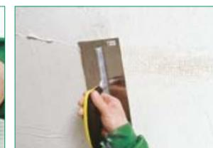
Redoublage de la 1<sup>ère</sup> couche frais sur frais. Surfaçage au couteau de 60. L'armature ne doit plus être apparente.
