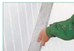
Pose des panneaux verticalement façon coupe de pierre et contrôle de la planimétrie.
