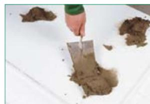
Mise en place des plots de calage ou de collage MAITE, puis pose des panneaux façon coupe de pierre.
