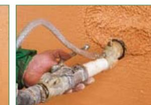
Exécution de la 2<sup>ème</sup> couche d'enduit 24 heures plus tard (en 1 passe pour l'enduit gratté et en 2 passes pour l'enduit rustique). Epaisseur totale 12 à 15 mm.
