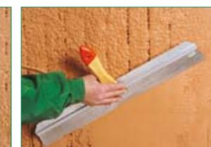
Serrage de la première passe d'enduit (l'enduit doit pénétrer dans les queues d'aronde).
